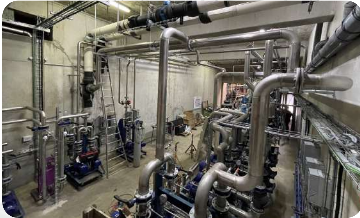
Réalisation d'un lot tuyauteries inox de DN25 à DN125 dans l'alimentaire
