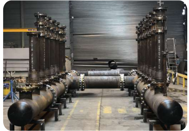
Réalisation d'une tuyauterie DN 500
