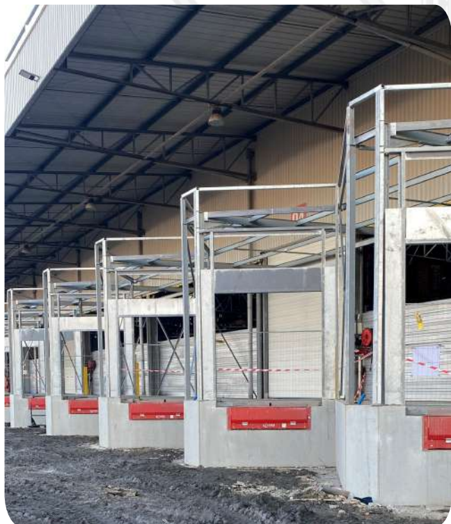
Structure de quais de déchargement
